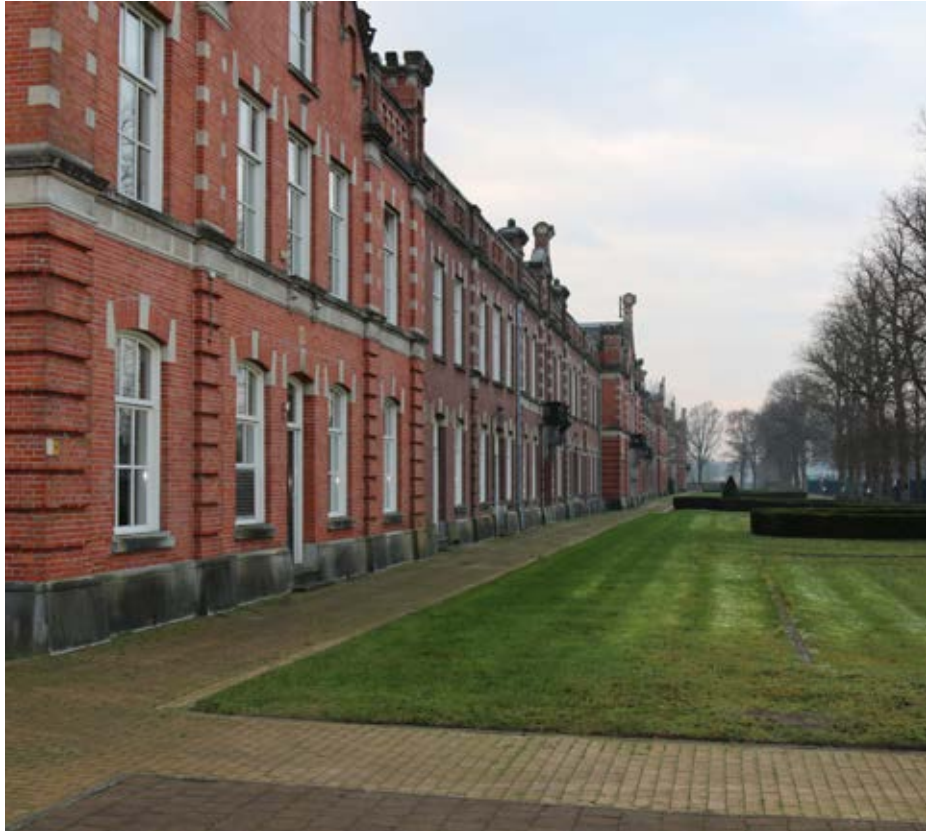
De monumentale panden van de Johan Willem Frisokazerne in Assen worden overgedragen aan het Rijksvastgoedbedrijf. De resterende locatie in Assen wordt vernieuwd en verduurzaamd.
